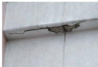
写真No.2 爆裂：上げ裏部分のコンクリートが欠損している
