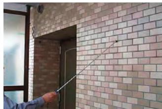
写真No.4 事前調査：打検棒でタイルの浮きを調査している
