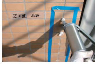
写真No.8 補修：タイル面のエポキシ樹脂注入作業
