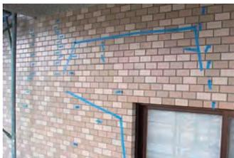
写真No.7 調査：タイル面の劣化をマーキングしている
