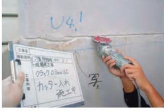
写真No.11 補修：塗装面のひび割れにUカット処理をしている
