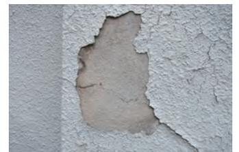
写真No.1 塗膜剥離：既存塗膜が剥離している
