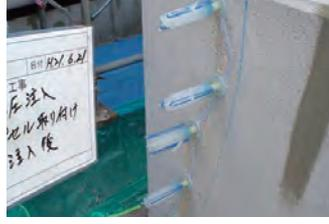
写真No.10 補修：塗装面のひび割れに低圧注入をしている
