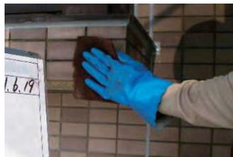
写真No.6 洗浄：タイル面の薬品洗浄作業
