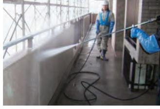
写真No.9 洗浄：塗装面の高圧水洗浄作業
