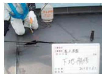
写真No.12 既存防水層の膨れ部を切開しトーチバーナーで炙り戻しを行っている。
