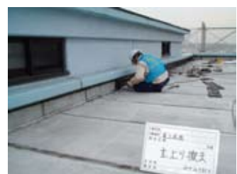
写真No.13 既存防水層の立上り部を撤去している。
