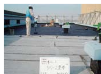
写真No.14 既存防水層に下地活性材を塗布している。
