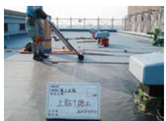
写真No.15 改質アスファルトルーフィング(2層目)を転圧ローラーを用いて敷設している。
