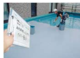
写真No.20 通気緩衝シートの上にウレタン防水材を塗布している。
